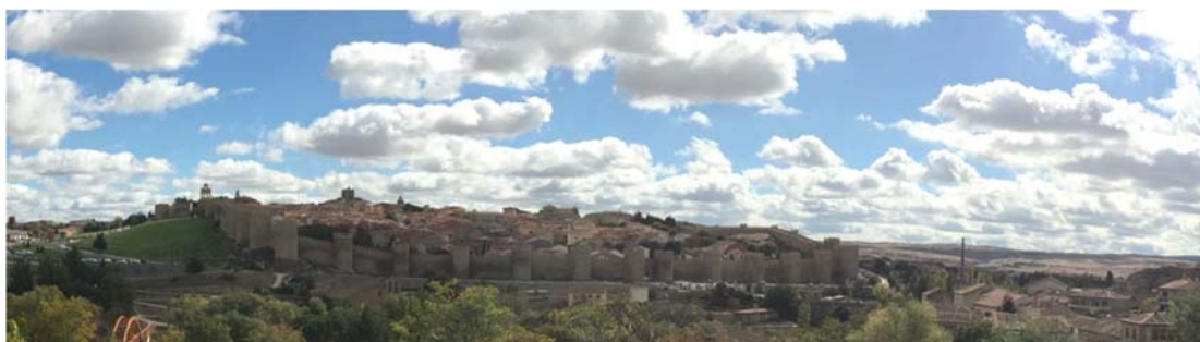
Ávila. Vista general desde los Cuatro Postes.
